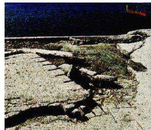
コンクリートがはがれ、使えなくなった本部港(塩川地区)の岸壁=8日午後
